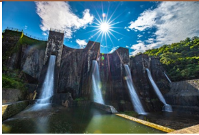
観音寺豊稔池ダム001
